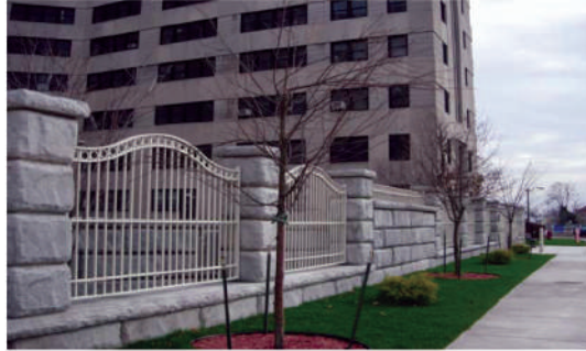
VA Hospital, Buffalo, NY
